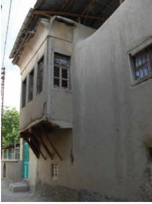
Şekil 7. Kurtaran Evi restorasyon öncesi
