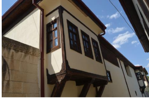
Şekil 8. Kurtaran Evi restorasyon sonrası
