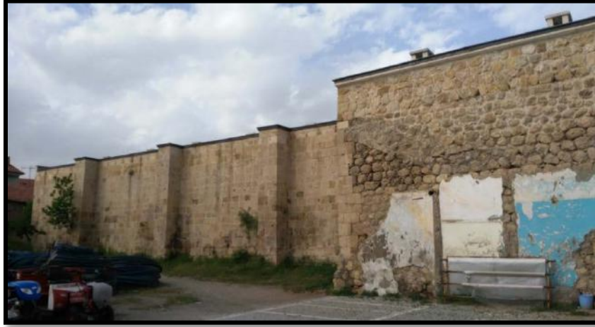
Şekil 24. Hekimhan Kervansarayı batı cephesi payandaları.
