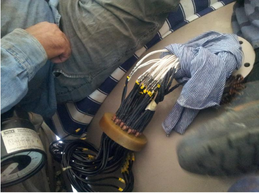
Şekil 4. Akım transformatörlerinin terminal ucu bağlantılarının sökülerek dışarıya alınması
